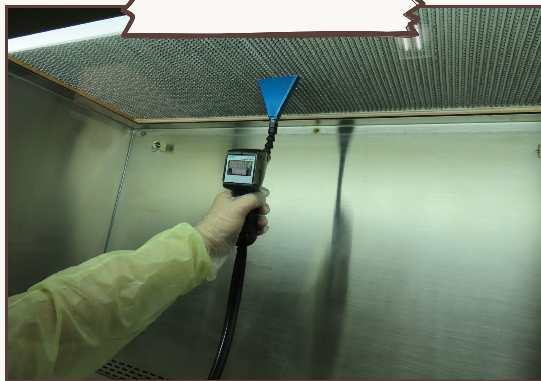
供氣濾網洩漏測試
