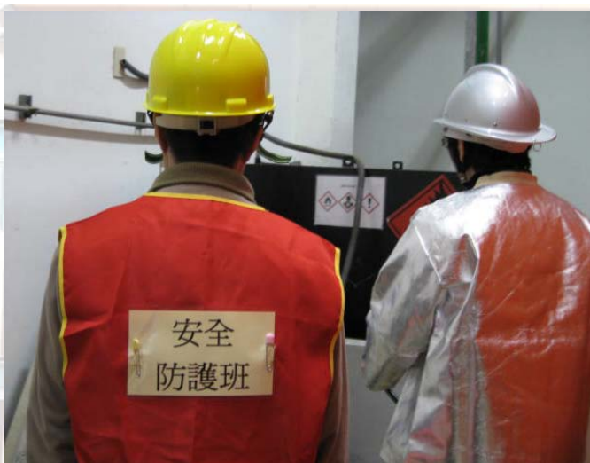
圖 7、危險物品(柴油槽)安全確認及警戒。
