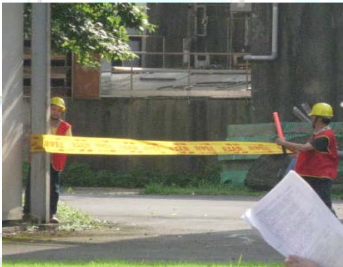
圖 7、安全防護班完成警界區的警戒帶架設。
