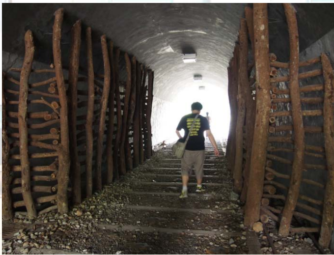
圖 8、穿越「新福本坑」彷彿走入時光隧道 體驗懷舊年代。
